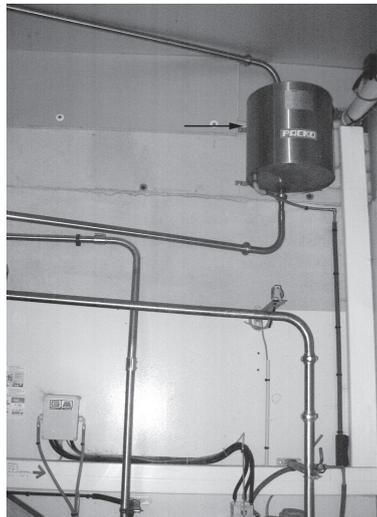
entre la pompe à lait et le tank : "avant d'aller dans le tank, le lait passe dans le pré-refroidisseur, dans lequel circule à contre-courant de l'eau froide". Le lait se refroidit (à
