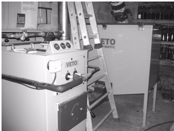
"Une chaudière rustique", avec une trémie d'un mètre cube
