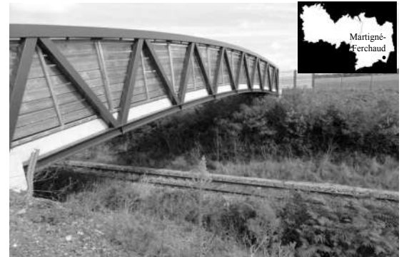
La passerelle construite au dessus de la voie ferrée a été financée par le réseau ferré de France, le Conseil Général d'Ille-et-Vilaine et une indemnité parlementaire.
