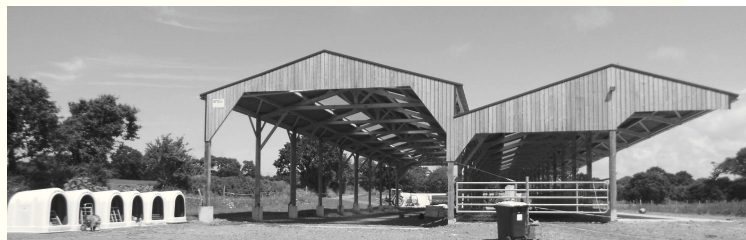
Le bâtiment construit à l'installation est multi-fonction : table d'alimentation de 55 places, stockage de fourrage. L'hiver, une partie du bâtiment est utilisée comme aire paillée, isolée du vent par des murs en paille.
